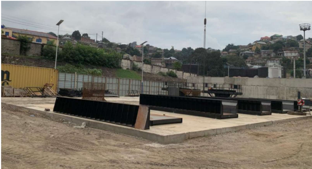
Photo n°12 : Aire de préfabrication
