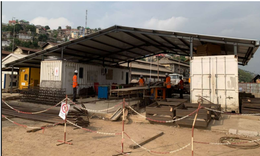
Photo n°10 : Atelier de ferrailage
