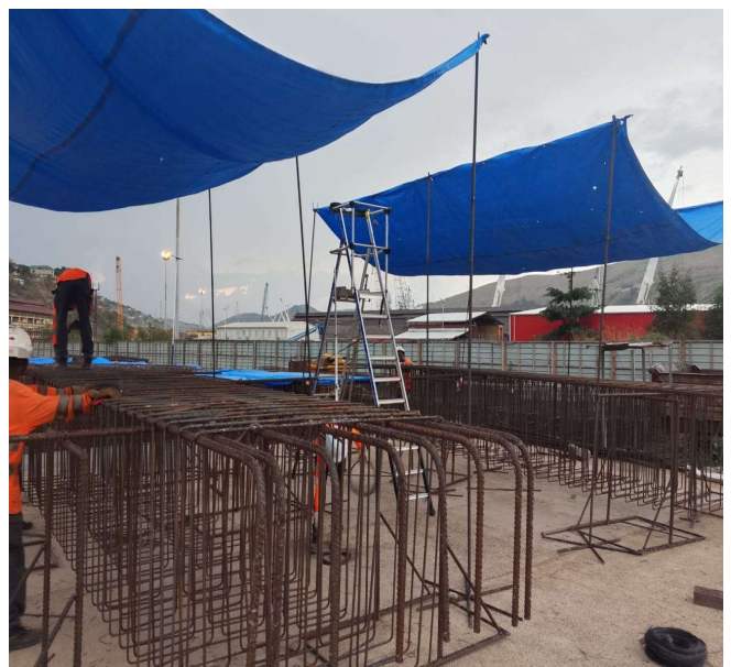
Photo n°21 : Assemblage poutre pl2-b et pl3-b
