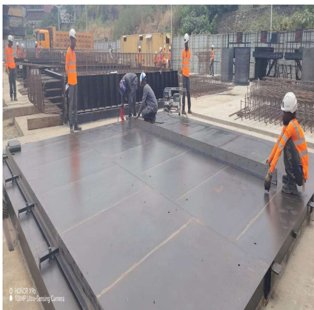
Photo n°20 : Montage coffrage du prédalle pd5-a
