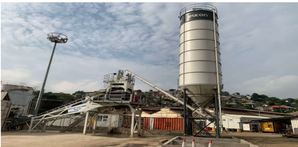
Photo n°6 : Centrale à béton
