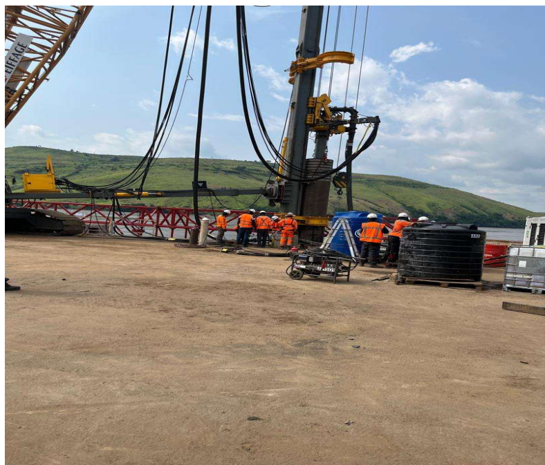
Photo n°17 : Forage des pieux
