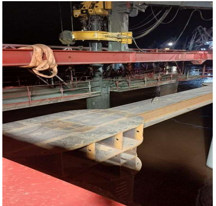
Photo n°16 : Préparation et forage du pieu p-012d
