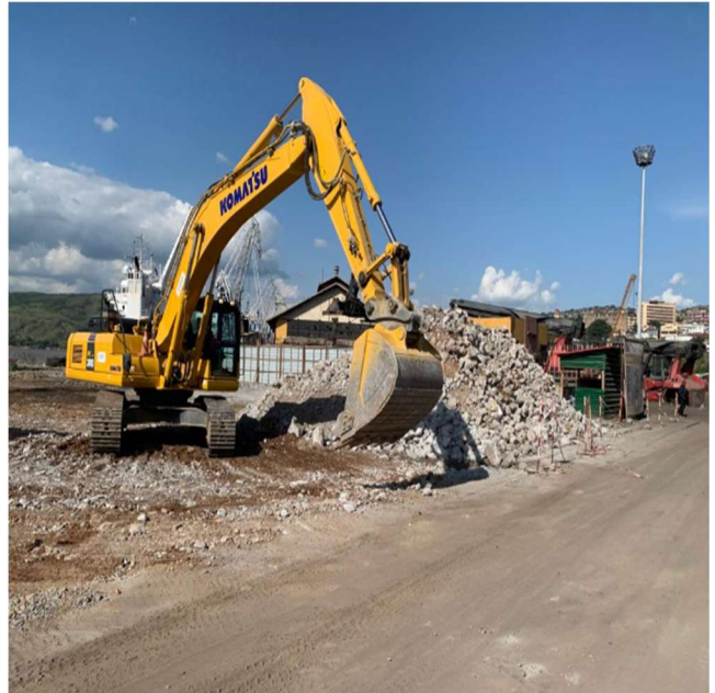
Photo n°19 : Gerbage des gravats zone 3
