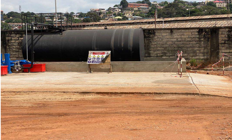
Photo n°3 : Cuve de stockage de carburant
