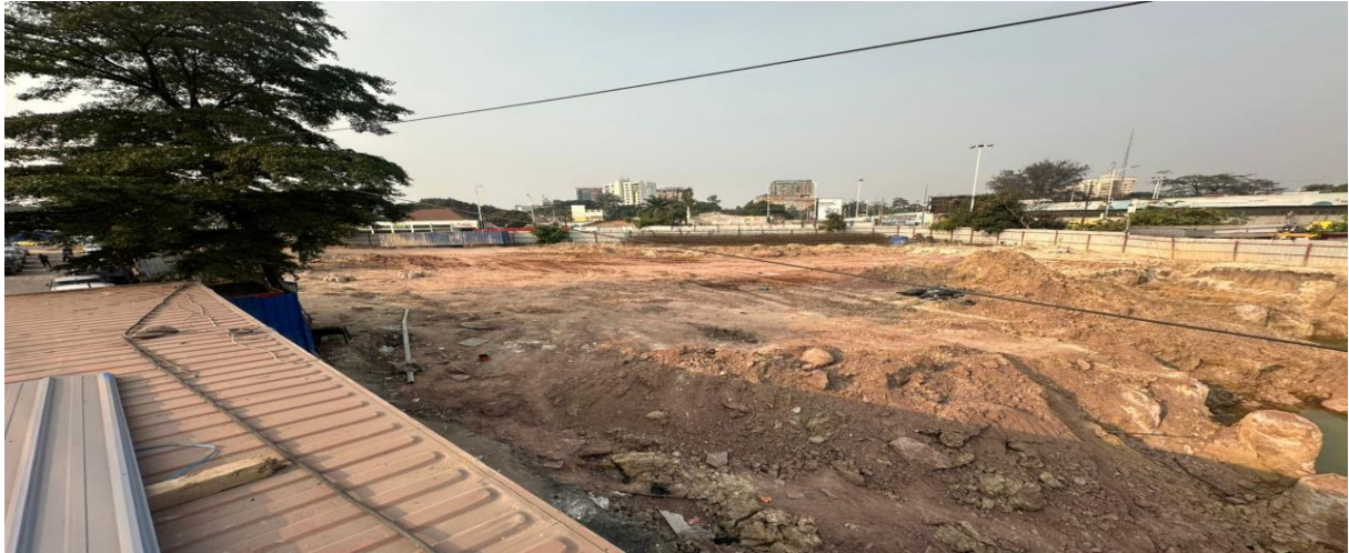
Photo 3 : vue des travaux de terrassement du site du projet
