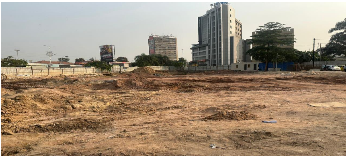
Photo 3 : travaux d'aménagement du site de construction de l'Immeuble
